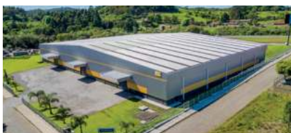
DIVISIÓN ALMACÉN CERRADO TRÊS LAGOAS | DIVISION CLOSED WAREHOUSE TRÊS LAGOAS
